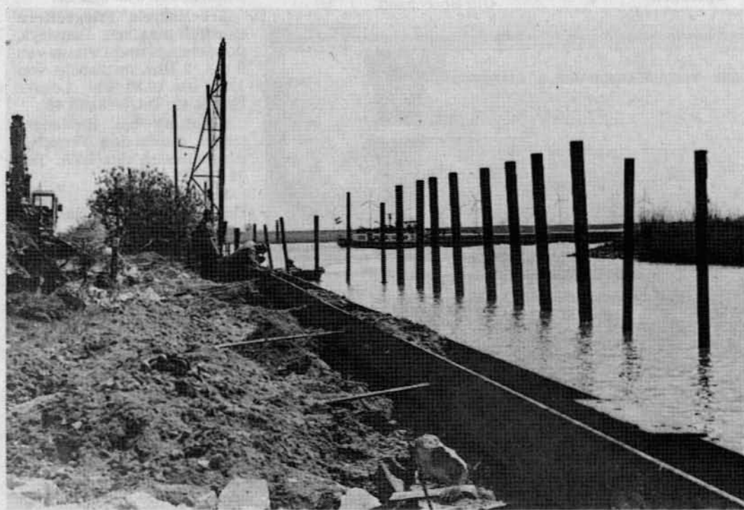
Im Rohbau ist die neue Spundwand im Jemgumer Hafen fast fertig.
