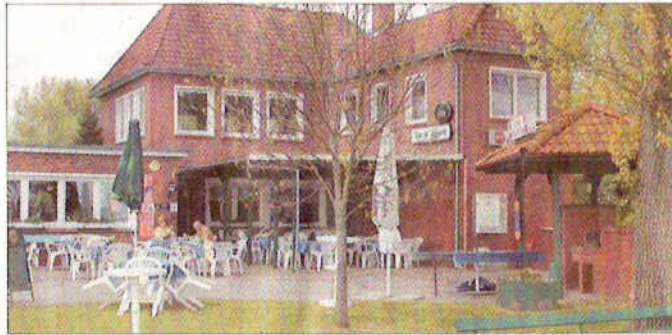
Abserviert: Die Gaststätte »Luv up« in Jemgum ist geschädigt. Durch die Ems? Das können die Lüneburger Richter nicht nachvollziehen.
