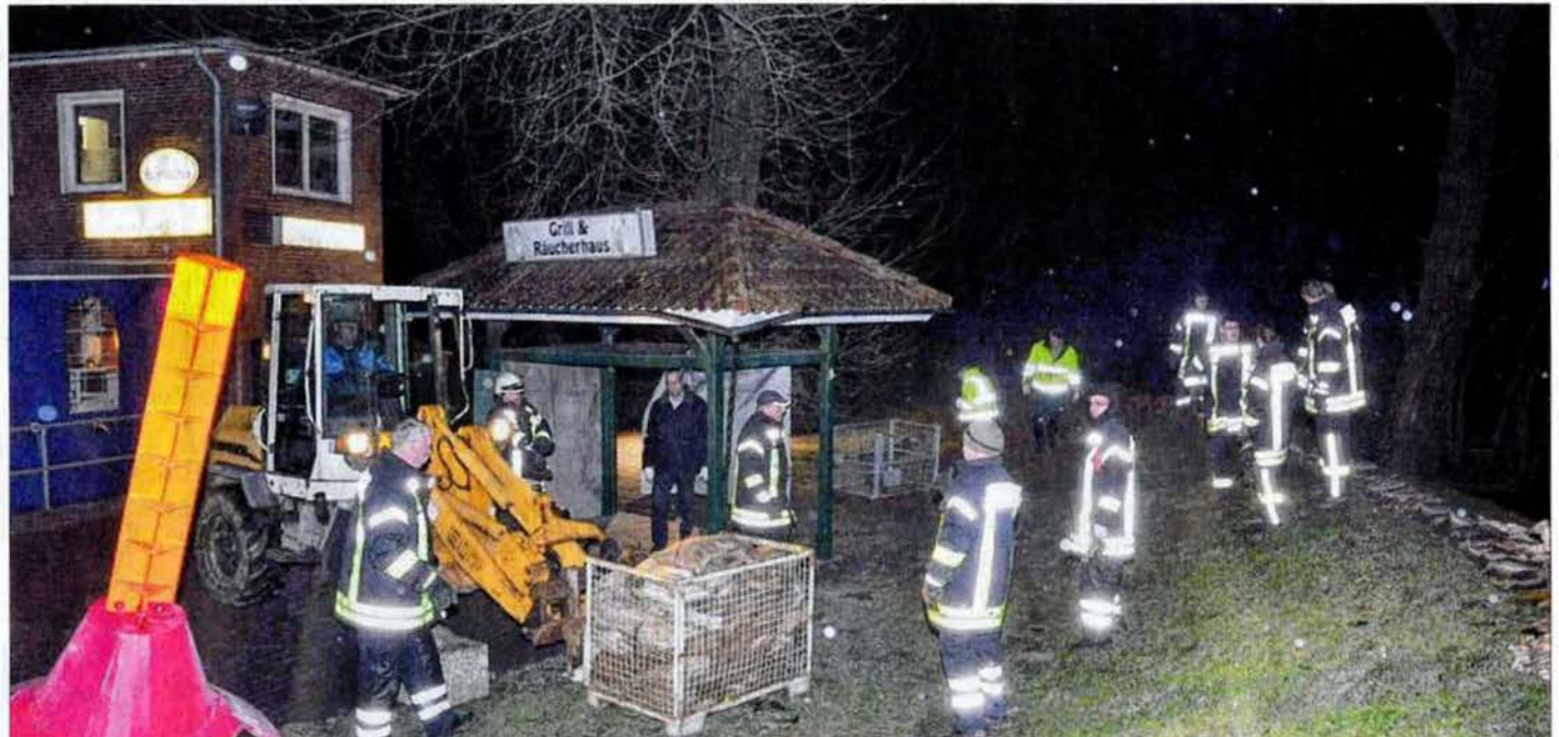
Mitglieder der Feuerwehr hatten anlässlich der Sturmflut am 11. Januar den Sommerdeich (rechts) bei der Gaststätte „Luv up“ mit rund 1000 Sandsäcken gesichert.
