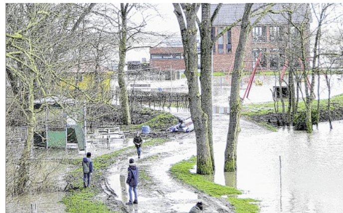
Das neue Vereinsheim Luv-Up hat durch das Wasser Schaden genommen.
